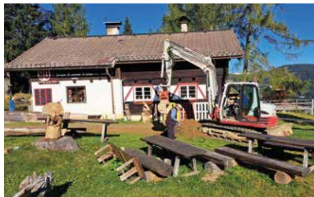
Arbeiten bei der Frido Kordon Hütte
