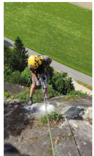
Bohren der Anker
