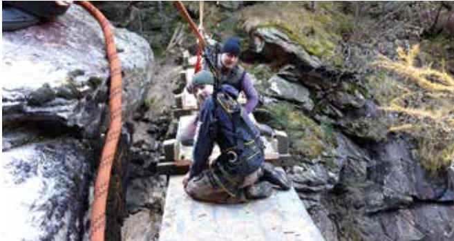
Abbau der Brücke
