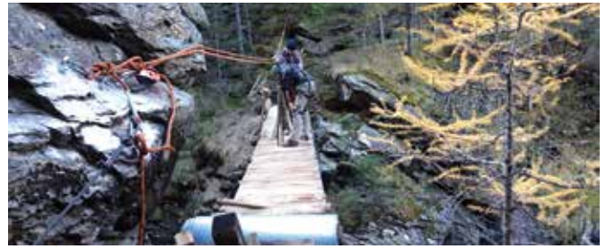
Arbeit wird gesichert durchgeführt
