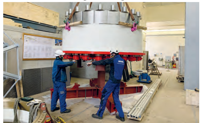
Sicheres Arbeiten unter Einhaltung der Abstände und mit persönlicher Schutzausrüstung
